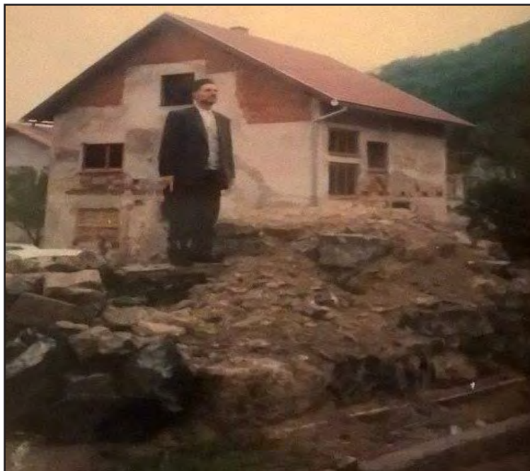
Ramiz-ef. Bećirović kraj srušene Sultan Bajazidove džamije u Jezeru.
